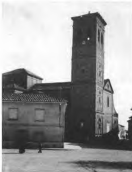
Fachada y torre de la iglesia de Santa Leocadia
