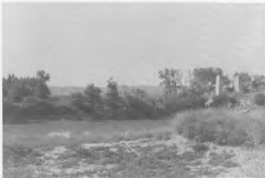
FOTO 8. Restos de los soportes del andarivel de la barca de Portusa (a la derecha).
