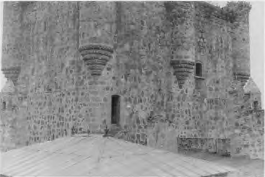
FOTO 25. Puerta abierta en la caja de escaleras de la Torre del Homenaje (s. XIX).
