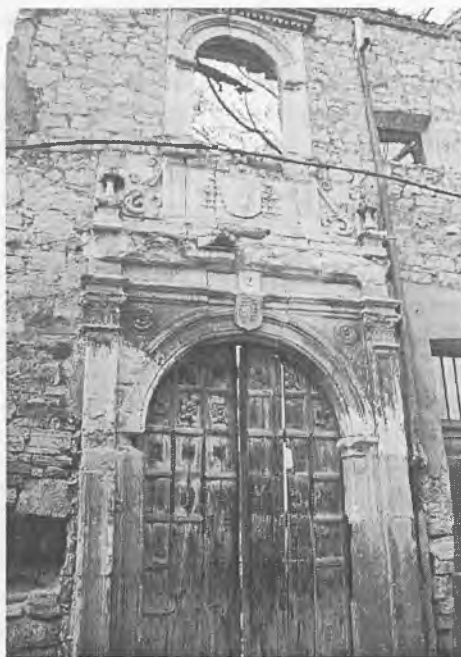
Fachada del Palacio de D. Fadrique de Portugal. Calle de La Yedra.
