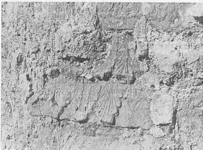
Fig. 9 y 10.- Fragmentos de componentes del claustro románico primitivo, reaprovechados en la cimentación del claustro actual (fotos José Juste).
