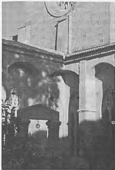
Fig. 5 y 6.- Foto de los años '20 en la que se aprecian las esperas históricas realizadas en el hastial septentrional del transepto para adosar posteriormente una torre que no llegó a realizarse, y fotografía del estado actual, tras las modificaciones efectuadas por A. Labrada en el transcurso de las obras de reconstrucción de los años '40 del siglo pasado.
