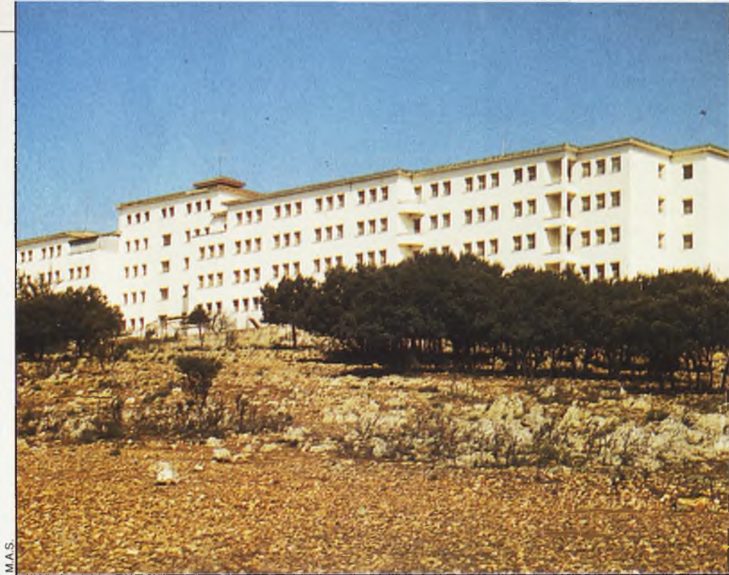
El centro de la Atalaya presenta importantes deficiencias en sus instalaciones, muchas de ellas deterioradas y obsoletas..
