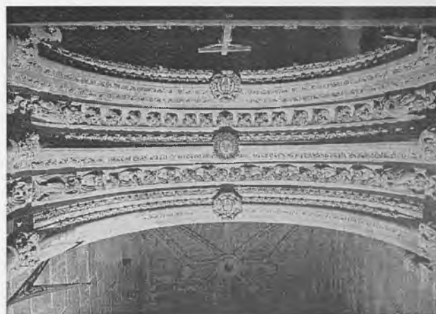
Intradós del arco de entrada a la Capilla de San Marcos
