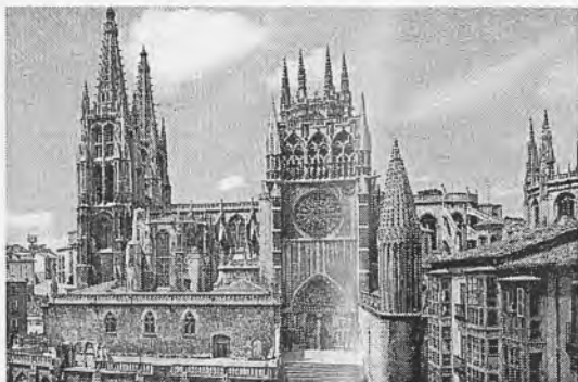
Fachada sur de la Catedral de Burgos
