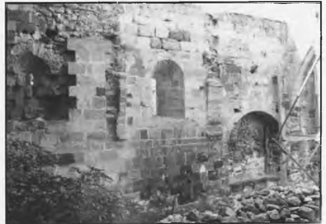
Cara interna del muro sur de la nave.
