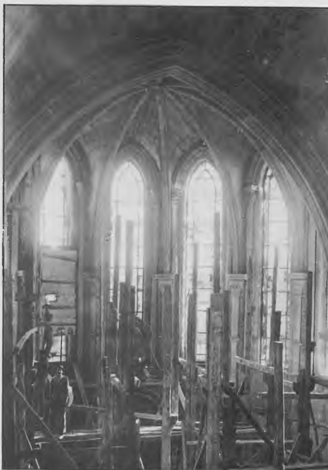
La Capilla Mayor de la Catedral, en pleno proceso de restauración
