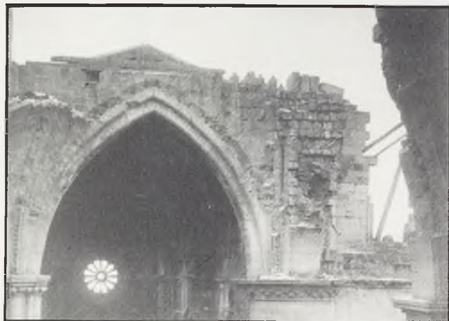
Las bóvedas central y norte del crucero destruidas.
