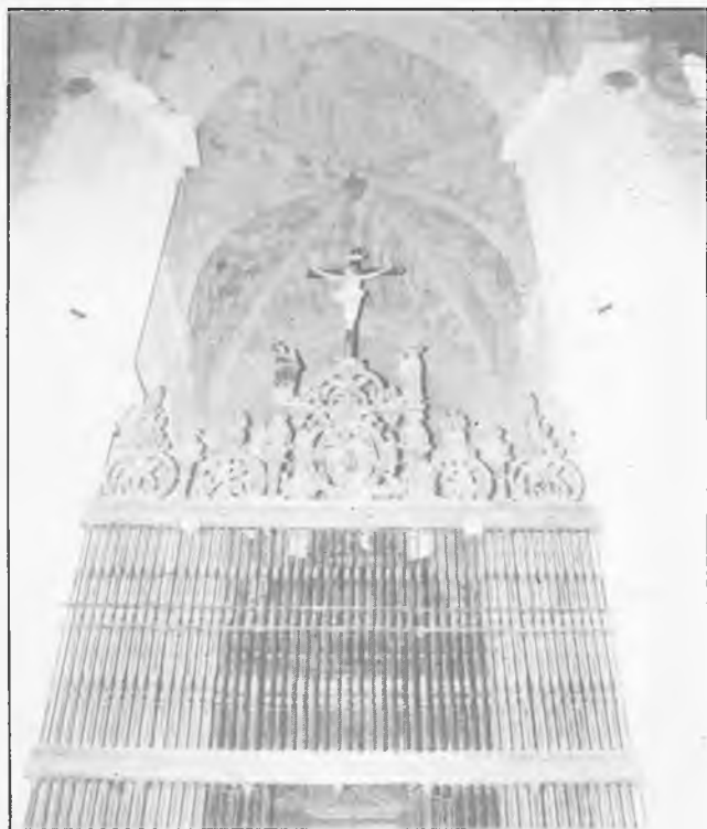
Arco central apuntado en el crucero de la Catedral
