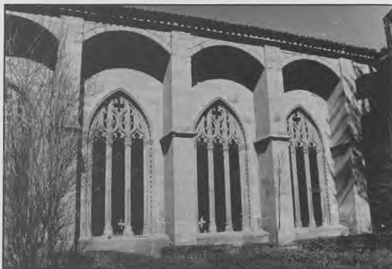
Ventanales de la panda sur del claustro
