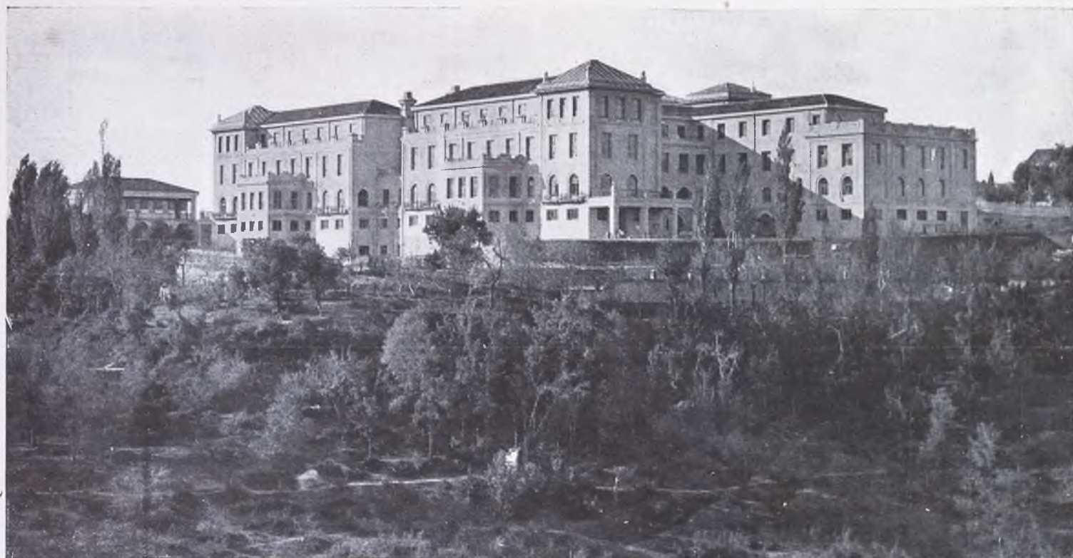
Vista general del Edificio
