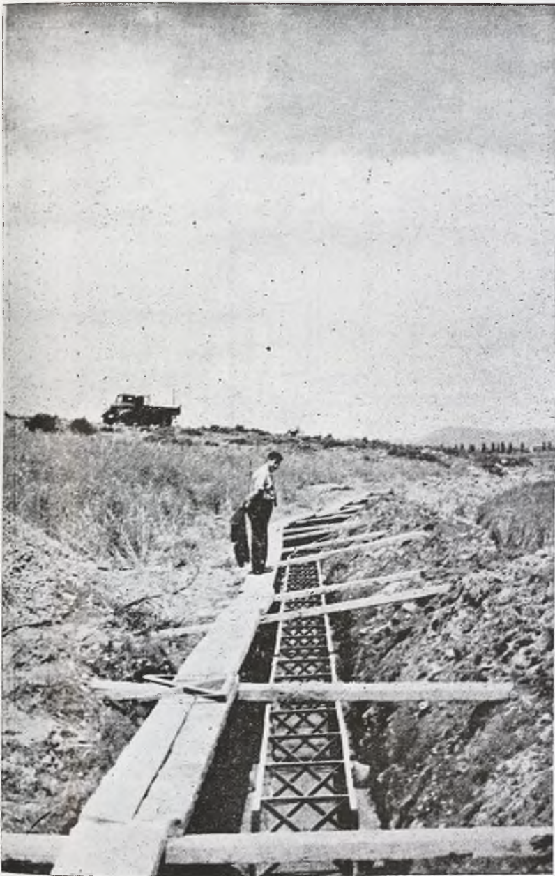
Canal normal.—Encofrados para cajeros.
