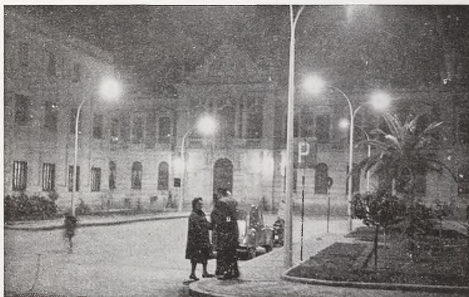
...se ha dotado de modernísima iluminación las principales vías de la Ciudad
