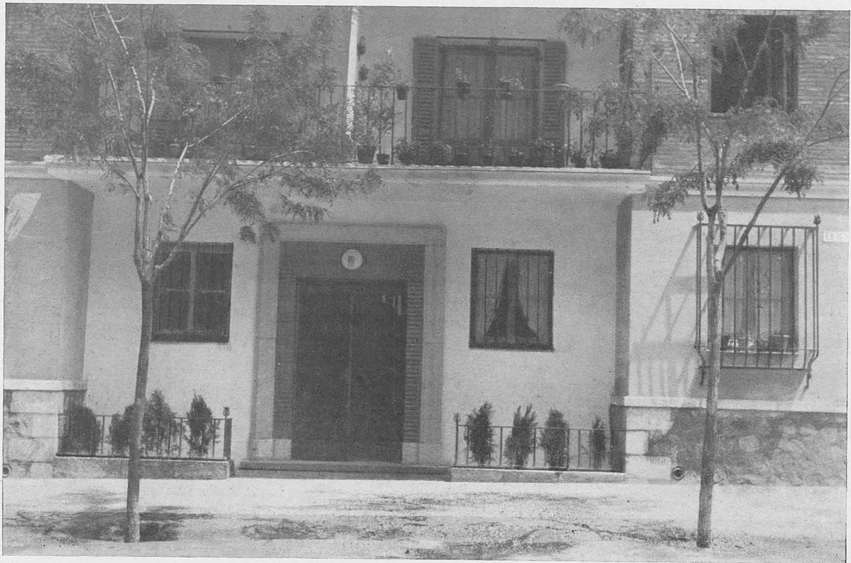
Detalle de entrada a una de las viviendas
