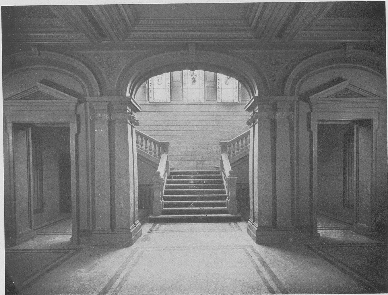
Gobierno Civil.—Vestíbulo de entrada.
