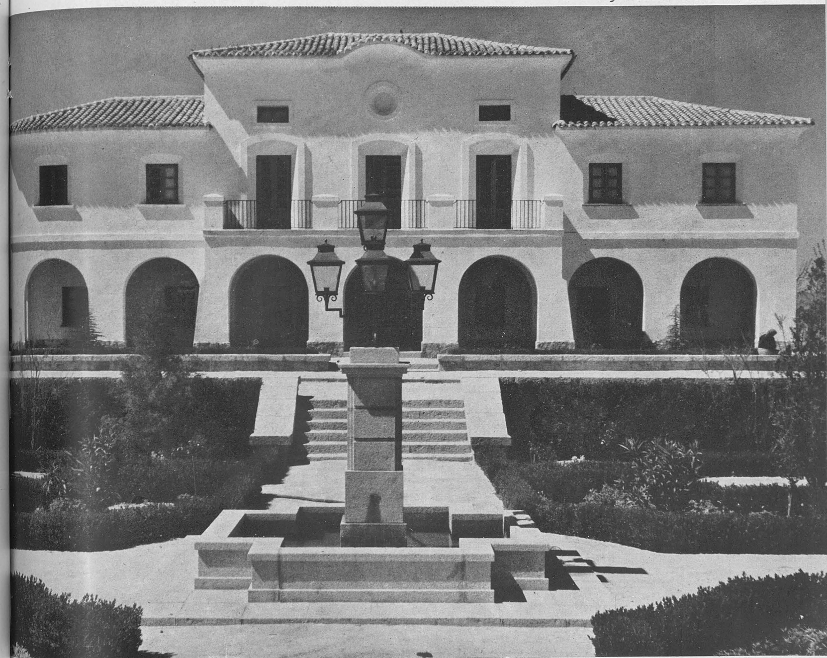
VILLANUEVA DE LA CAÑADA. Ayuntamiento. Fachada principal.
