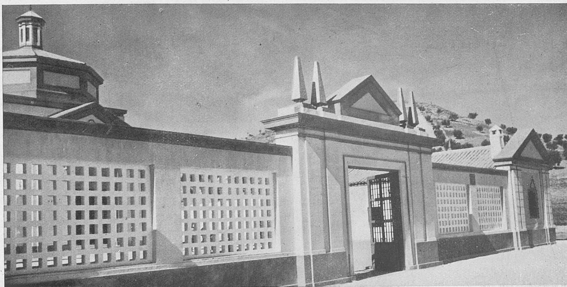
ALCALÁ LA REAL.—Cementerio. Conjunto y detalle de la entrada.
