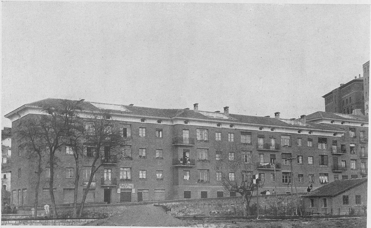
TERUEL.—Bloque de viviendas.
