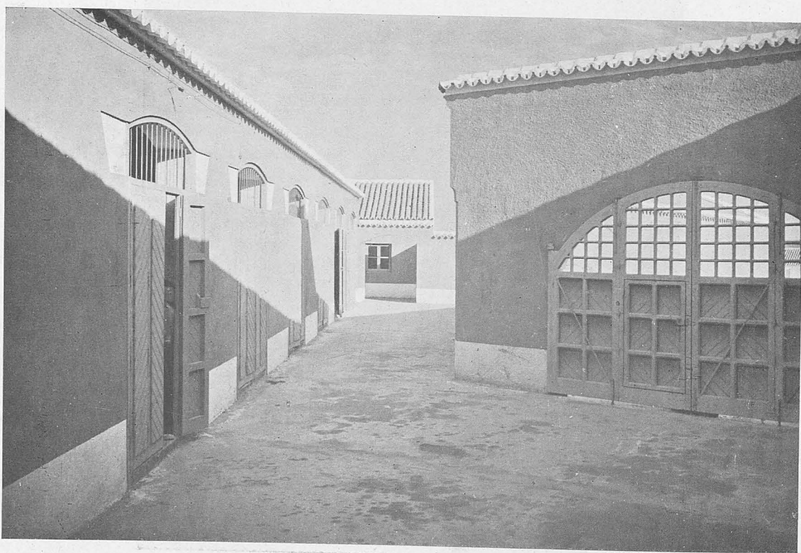
MARMOLEJO.—Jaén. Mercado de Abastos. Patio de almacenes.
