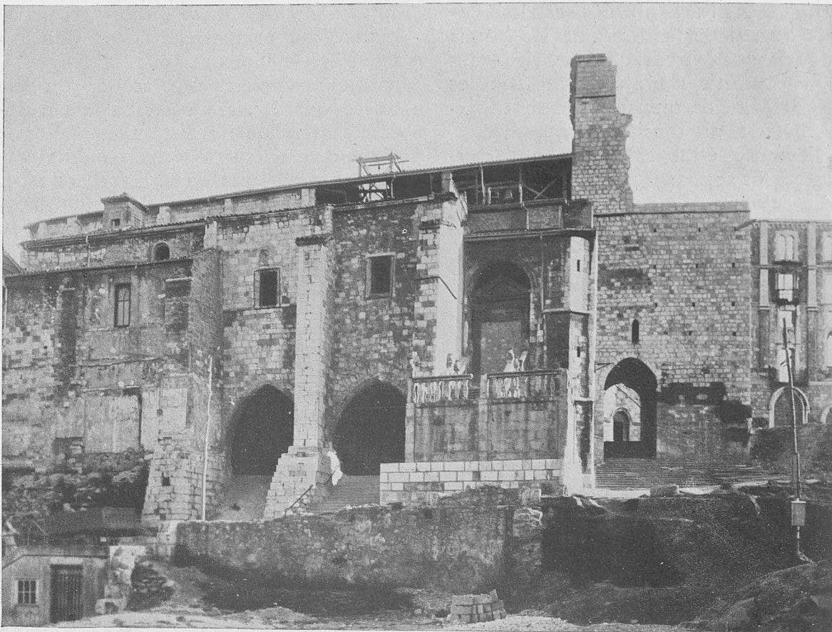
SANTANDER.—Fachada Norte, después del incendio de 1945.
