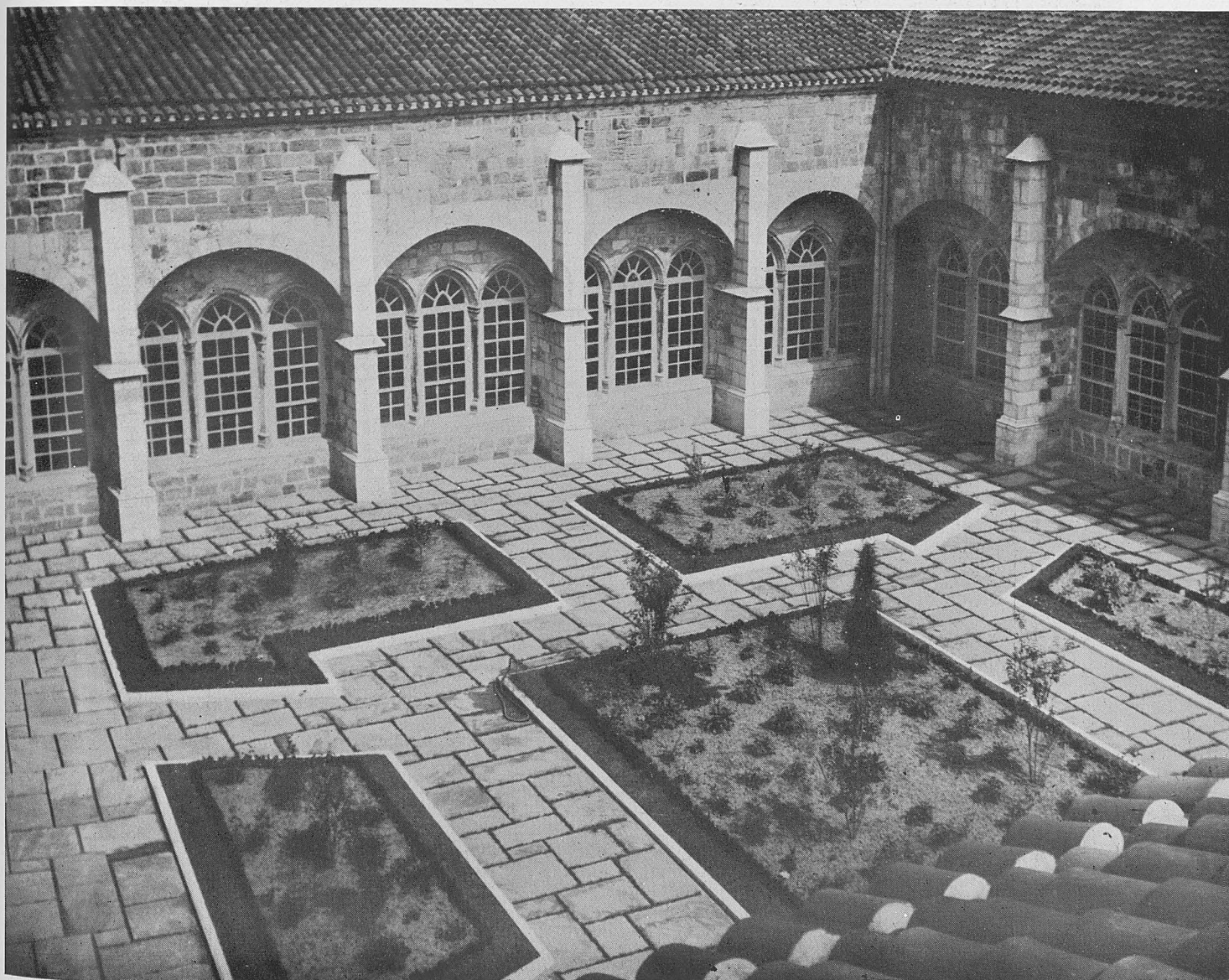
SANTANDER.—Catedral. Claustro. Pueden apreciarse en la fotografía los nuevos contrafuertes para evitar los empujes de los arcos.
