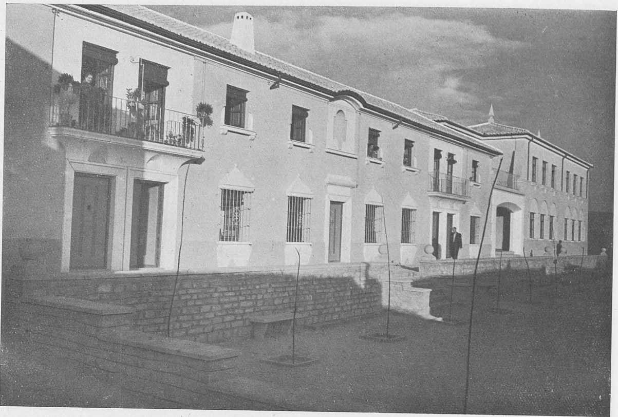
ARJONA.—Grupo Escolar y viviendas para maestros.
