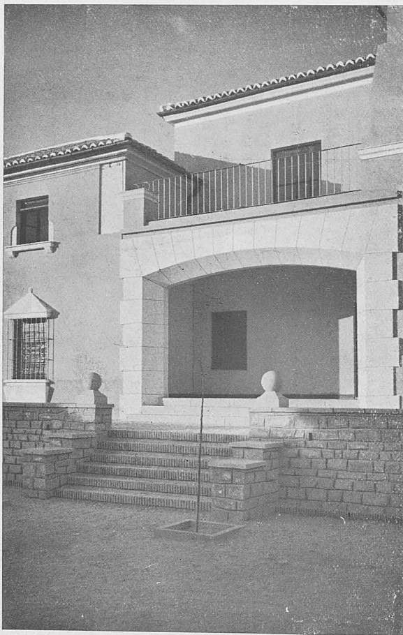
ARJONA.—Grupo Escolar y viviendas para maestros. Detalle de la portada.
