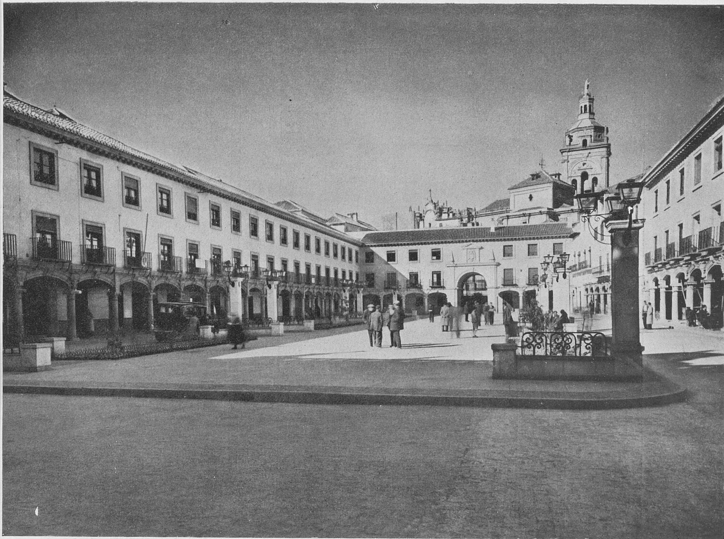
GUADIX.—Urbanización de la plaza. Conjunto.
