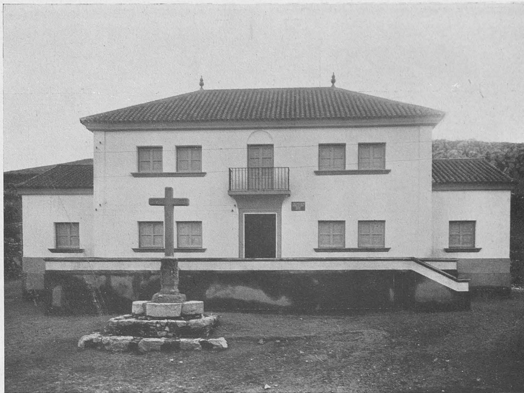
MOCLÍN.—Viviendas para maestros. Fachadas.
