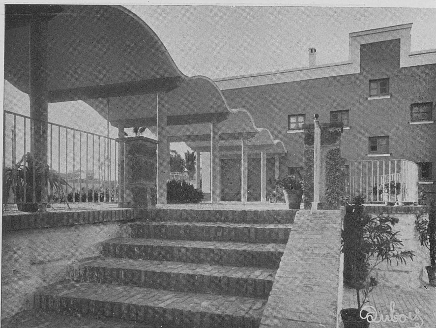
Detalle de una escalinata.
