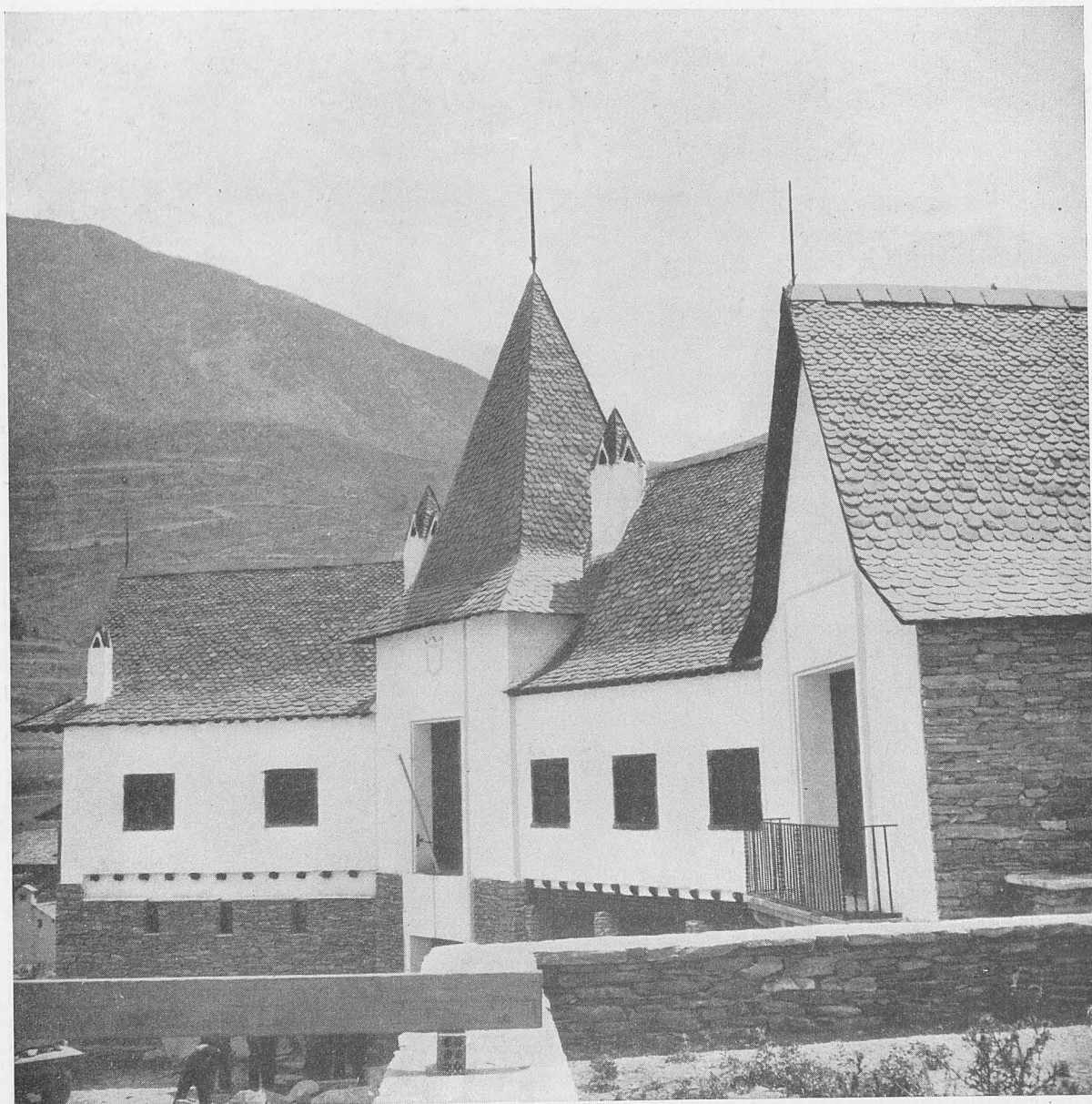
TIRVIA.—Ayuntamiento. Detalle de la cubierta.
