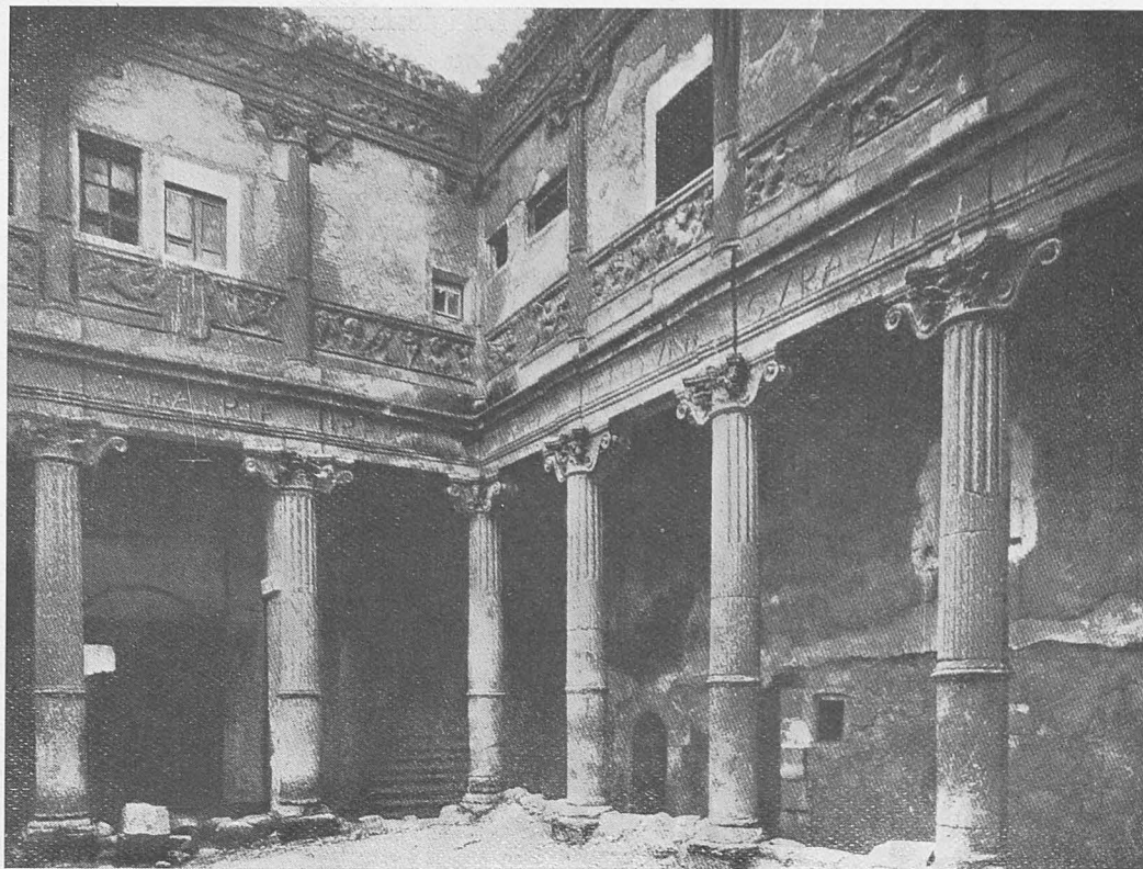
BURGOS.—Patio de la Casa de Miranda.
