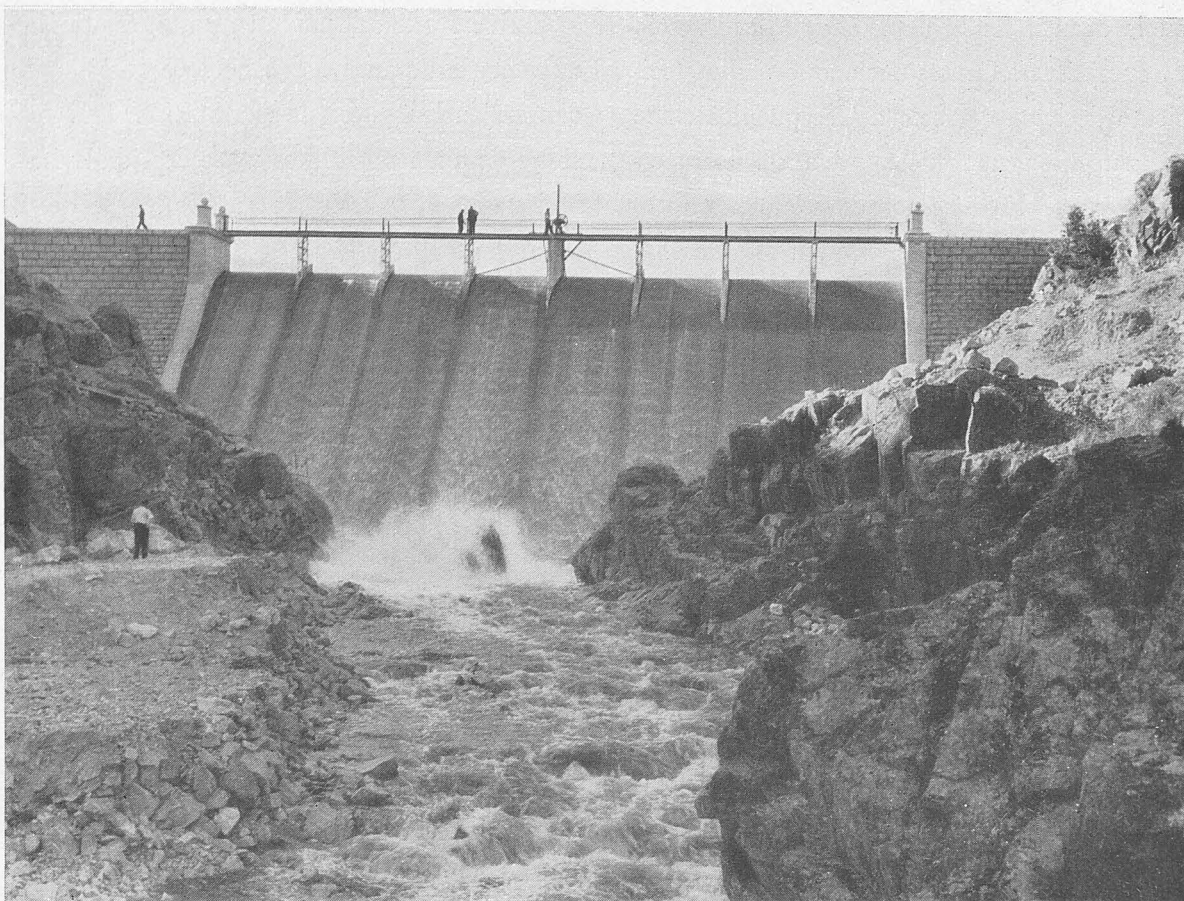
La presa desde aguas abajo.
