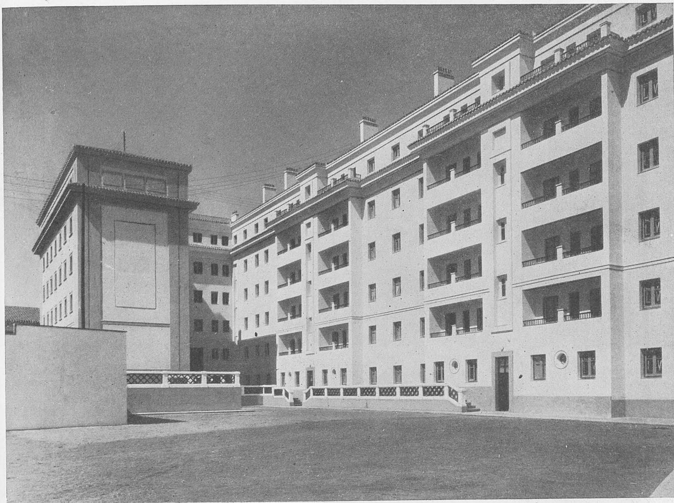
Fachada de patio interior.
