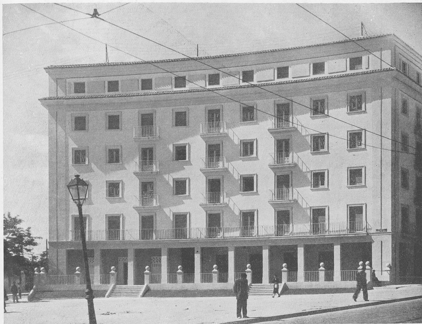
Fachada a la plaza del Marqués de Vadillo.
