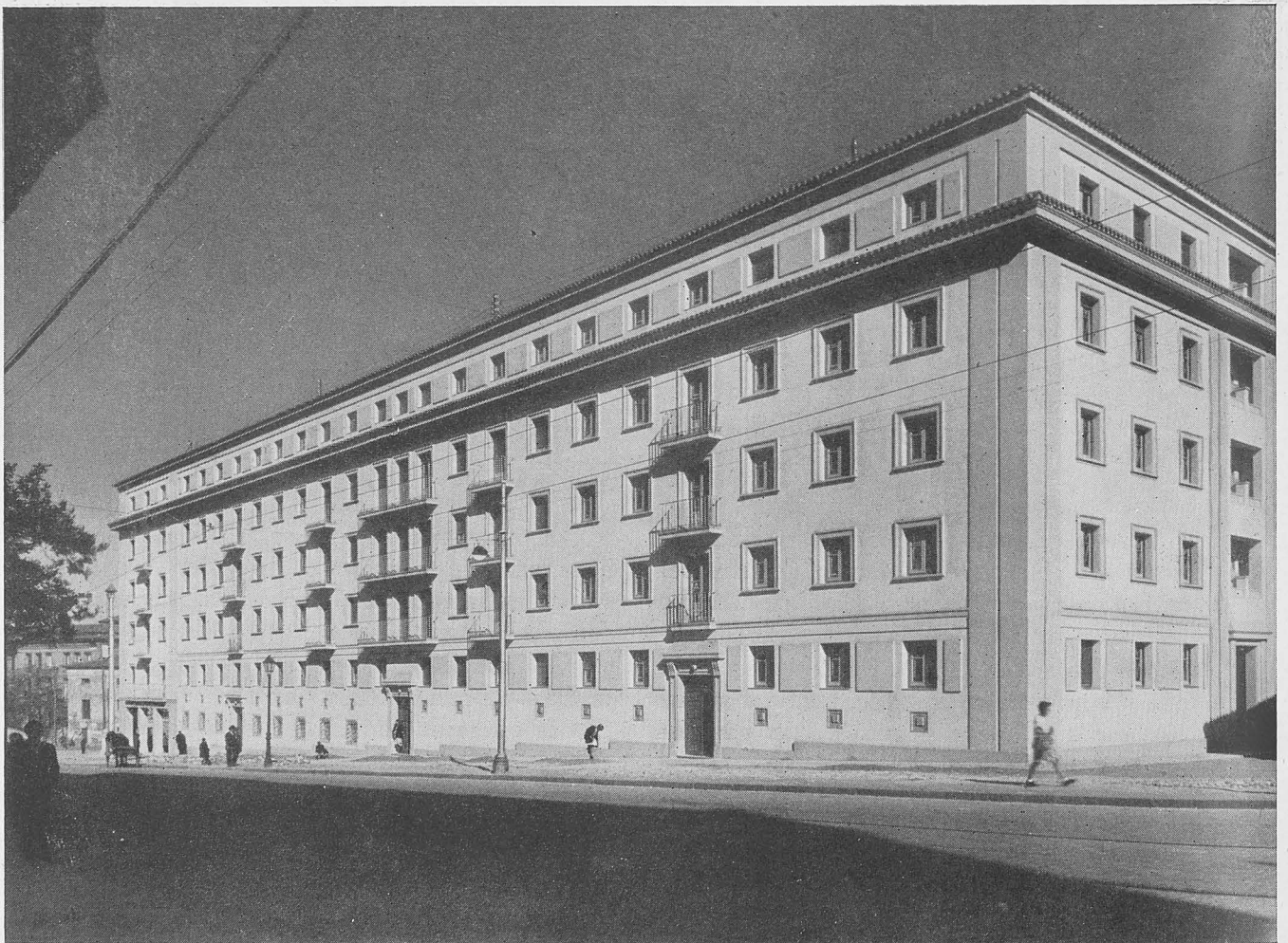
Fachada a la calle General Ricardos.
