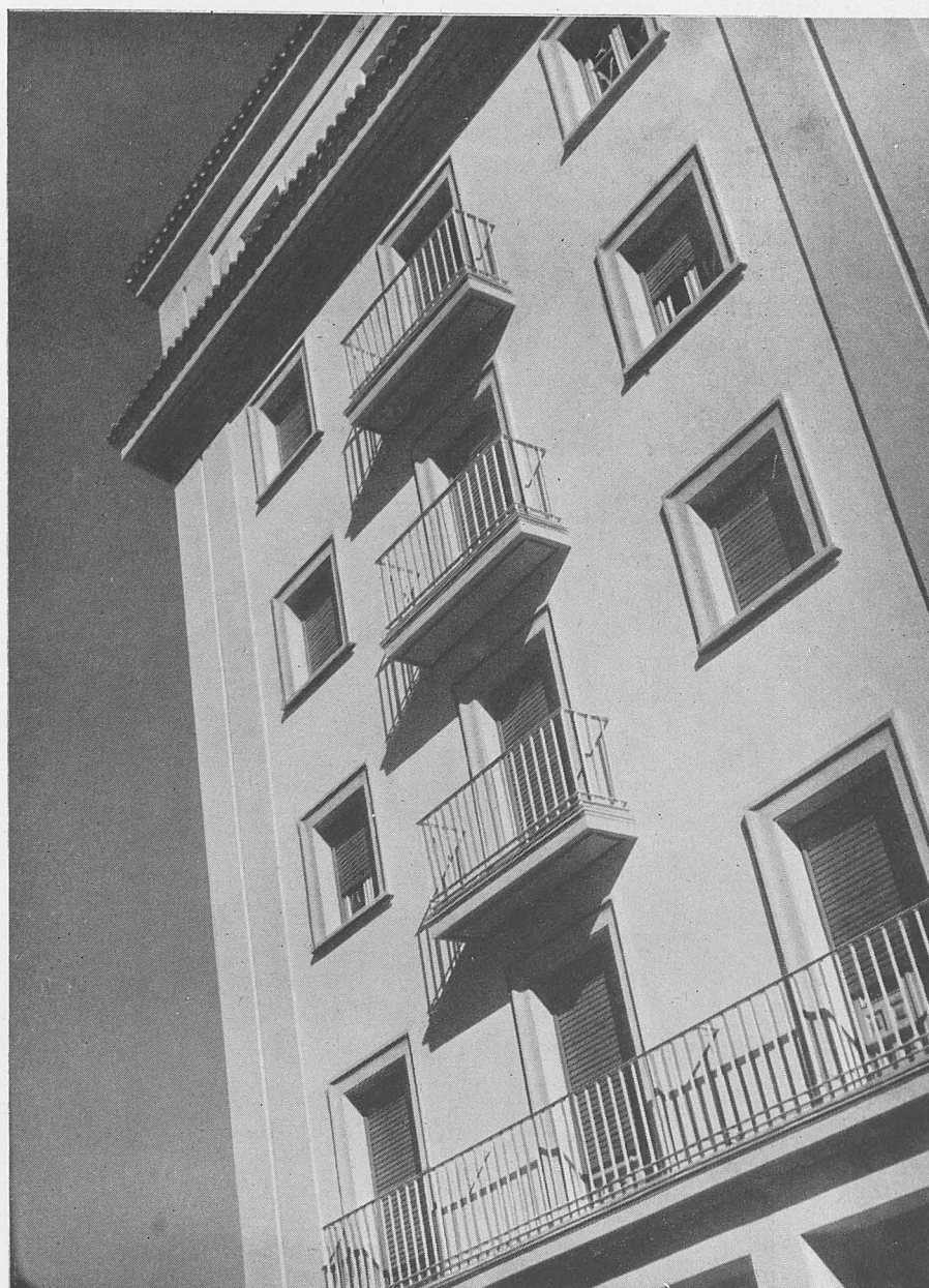
Detalle de fachada.
