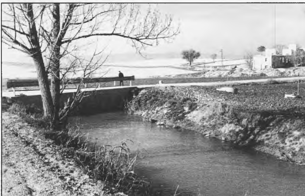
"La Máquina", en fechas próximas será demolida
