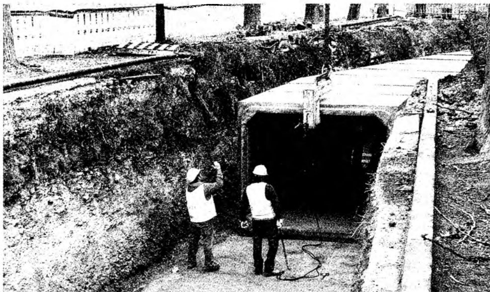
Instalación de marcos prefabricados de hormigón para la nueva canalización.
