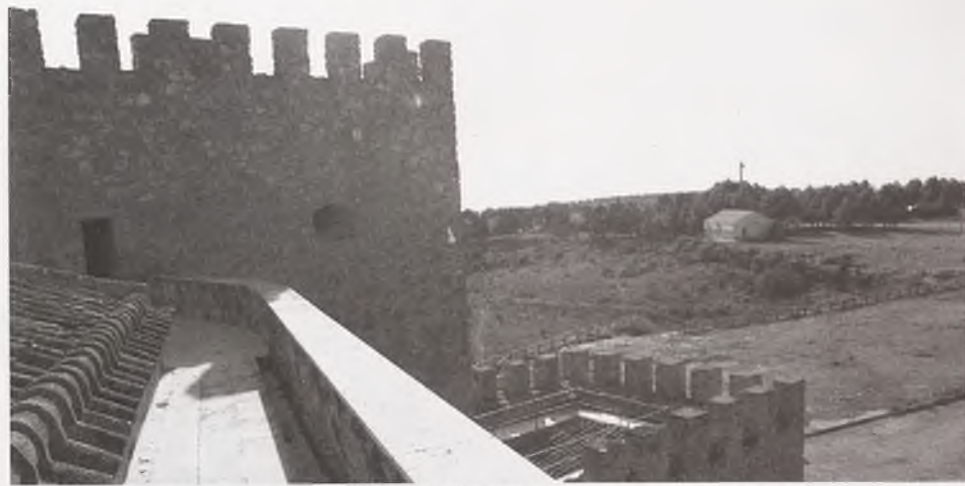
Vista de una de las torres del Castillo de Peñarroya.
