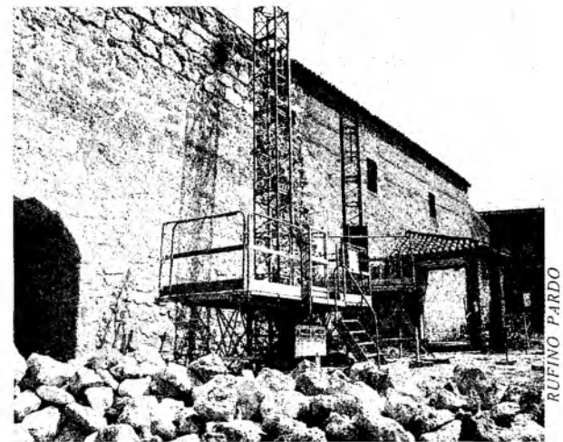
Detalle de las obras de reconstrucción del muro.
