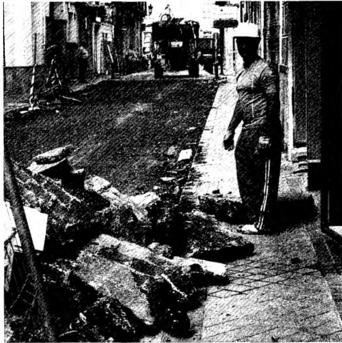
Imagen de las obras tomada el pasado martes.
