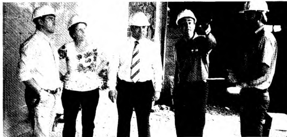
El alcalde, Carlos Cotillas, y los ediles, Luis Reguillo y Javier Navarro, en su visita a las obras.
