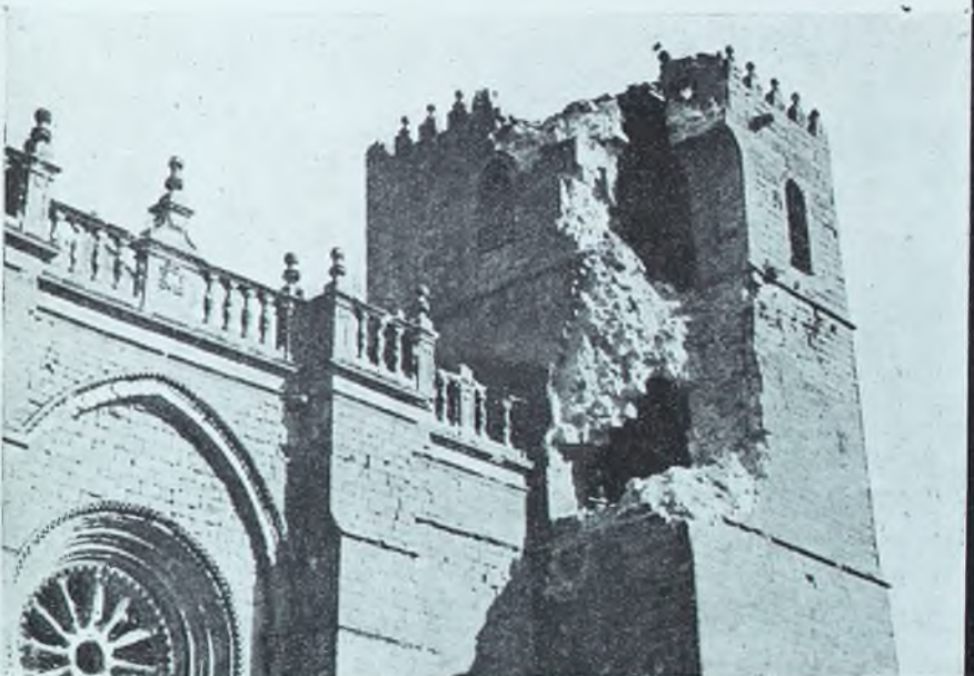
Efectos del bombardeo, en la torre de la Catedral.
