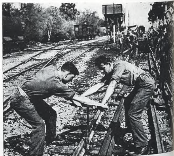
Soldados de Ingenieros británicos arreglando una línea férrea averiada, necesaria para llevar los pertrechos y suministros a la primera línea del frente en Túnez
