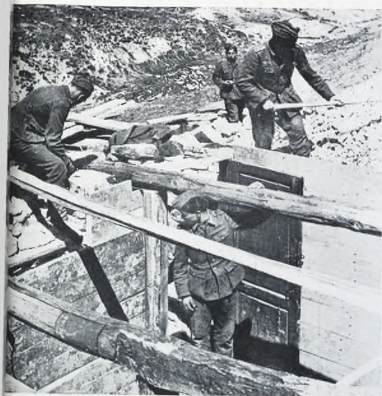
Soldados alemanes en Sicilia, construyendo un fortín más en la interminable serie de los que defienden las costas mediterráneas del Eje
