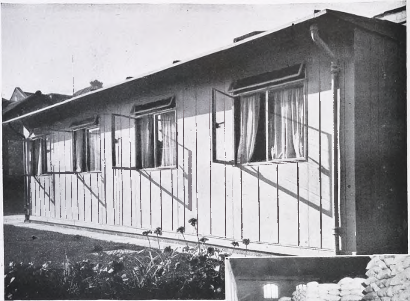
Modelo de casa provisional de fabricación británica construido en su mayor parte de acero y aluminio, que, fabricadas en gran escala, va facilitando el acomodo provisional de millares de familias sin hogar
