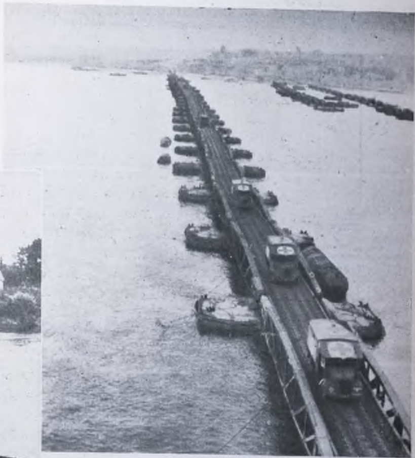
Puente flexible compuesto de docenas de pequeños tramos de acero, complemento de los muelles flotantes. Muelle y puente de construcción inglesa Montaje de un puente provisional inglés sobre el Sena
