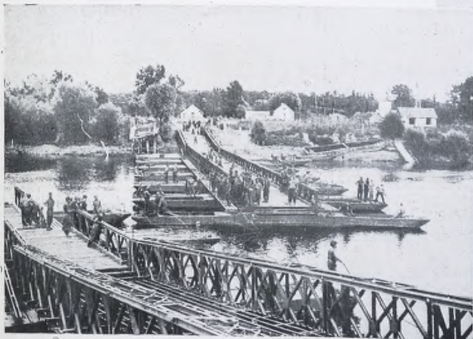
Puente flexible compuesto de docenas de pequeños tramos de acero, complemento de los muelles flotantes. Muelle y puente de construcción inglesa Montaje de un puente provisional inglés sobre el Sena
