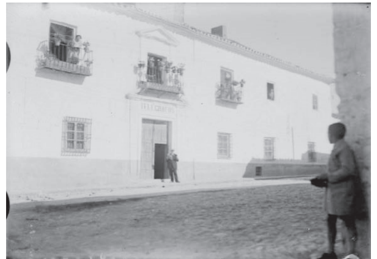
Antigua Casa de Correos y Telégrafos, que debido a su estado ruinoso, tuvo que ser derruida. En su solar se construyó el actual edificio de Correos.
