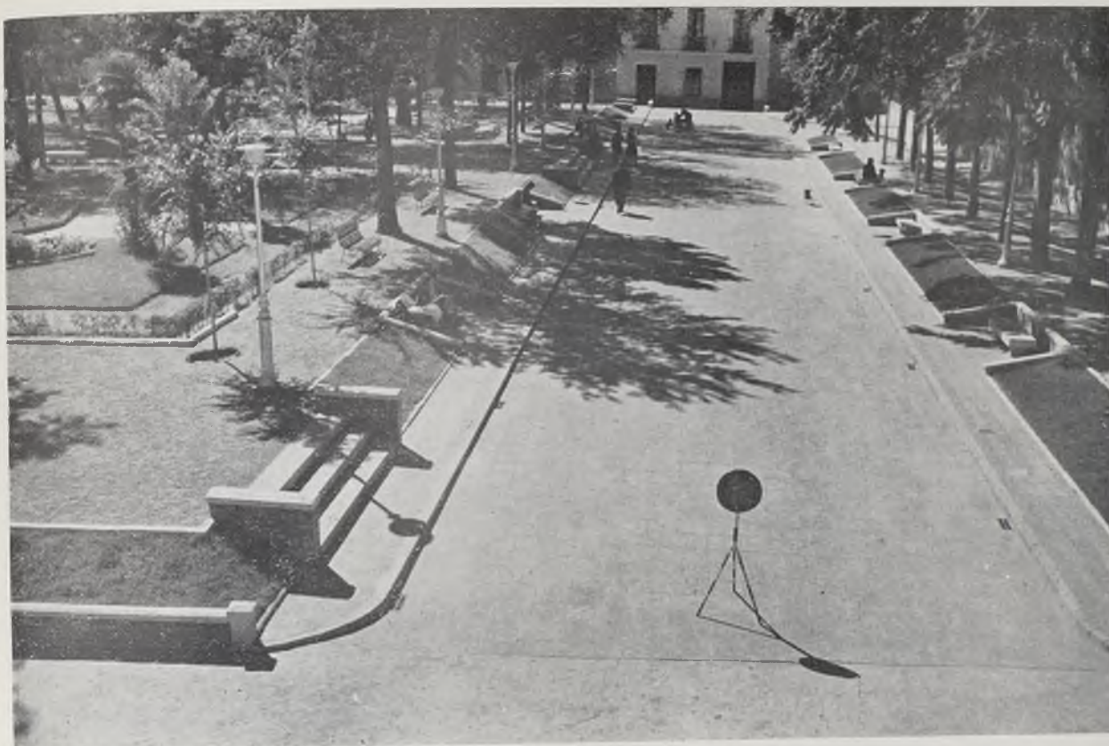
Una foto parcial del Prado, después de la última reforma. A la vista de la foto, sobran los comentarios.
