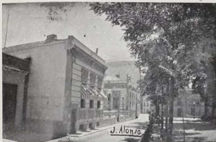
El Casino y la antigua barandilla del Prado.
