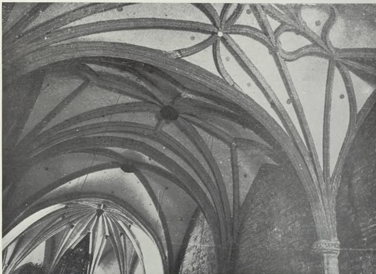
La Travesía de las bóvedas refleja las distintas etapas de su construcción
