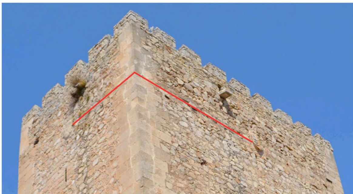
Situación a idéntica altura (8,55 m). Fachadas Sur (izq.) y Oeste (dcha.)
