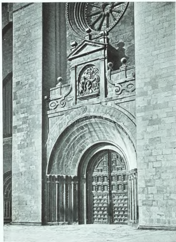
PUERTA CENTRAL DE LA FACHADA PRINCIPAL
