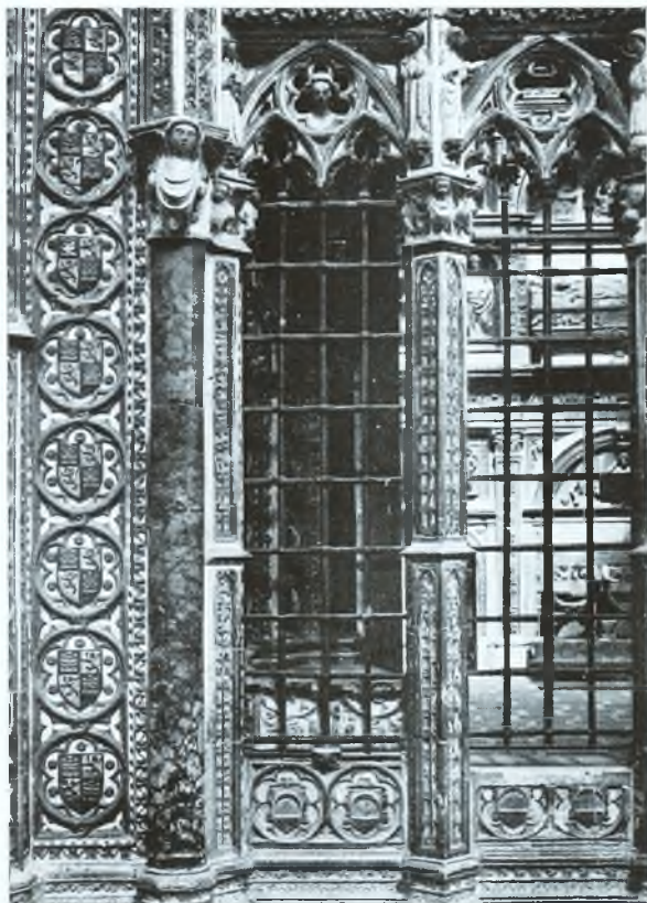
CAPILLA MAYOR. COSTADO LATERAL. DETALLE DE LOS VENTANALES. SIGLO XIV
