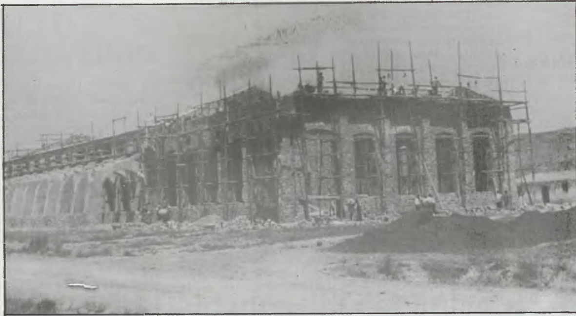
Obras de construcción de una subestación. Septiembre de 1948
