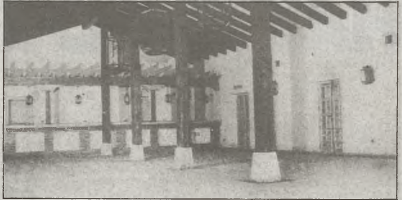
Vista parcial del salón y bar del hotel municipal
