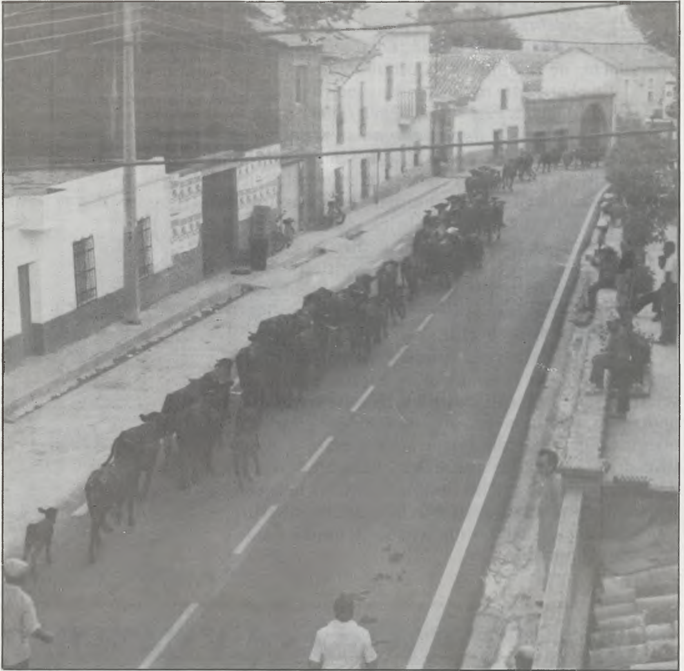
Sobre una antigua cañada real se construyó la aldea de Ruidera.
