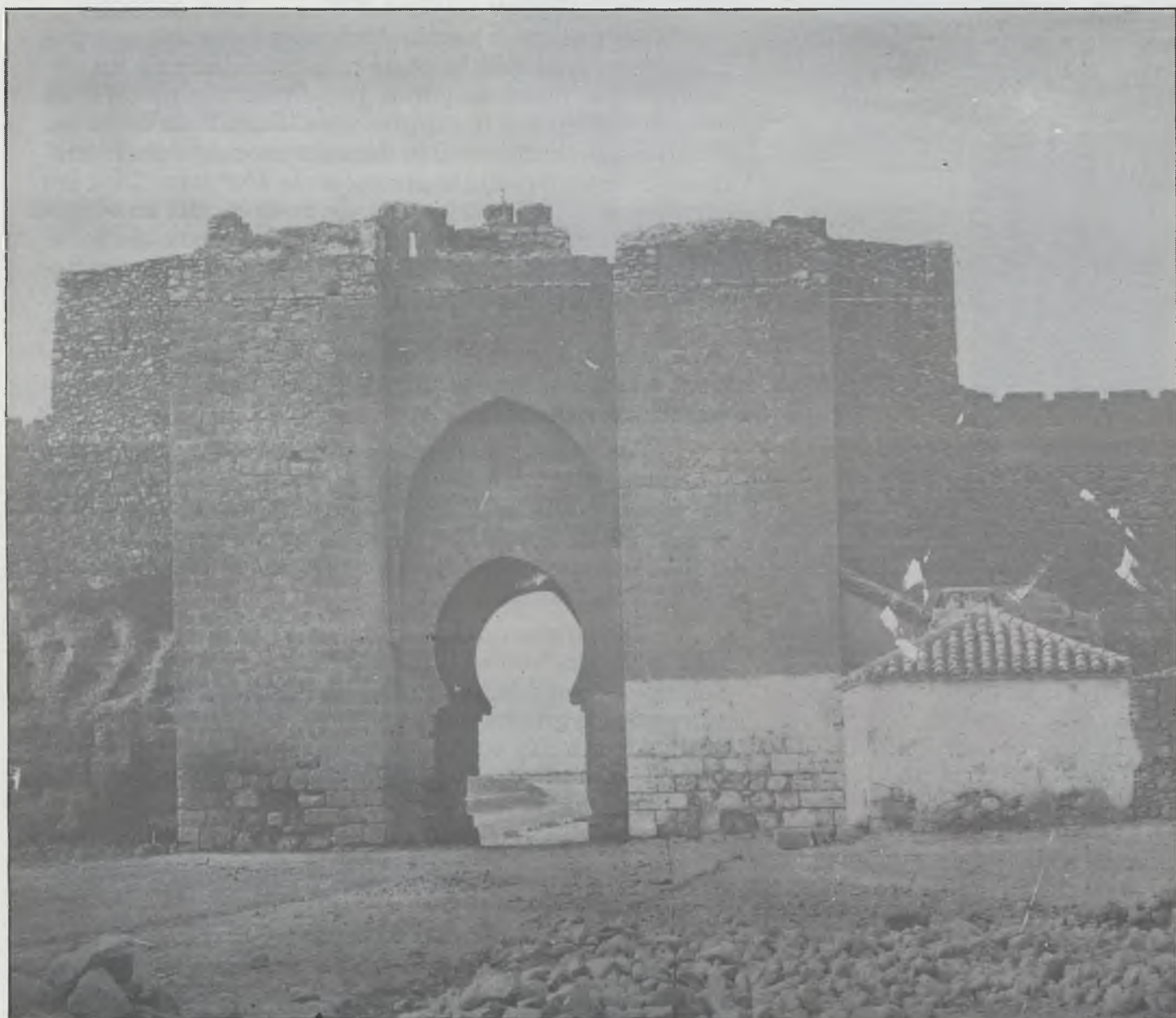
Puerta de Toledo (Ciudad Real); resto de la arquitectura militar del siglo XIV. Estado en que se encontraba por los años veinte
