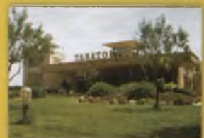
Zona Ajardinada Amplios Aparcamientos
