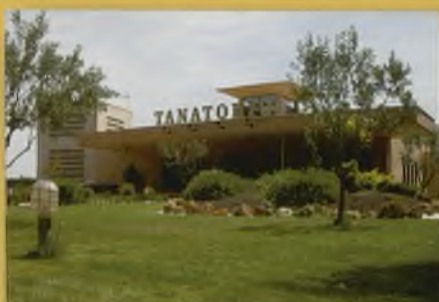
Zona Ajardinada Amplios Aparcamientos
