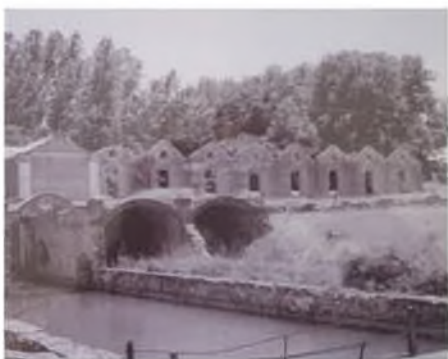
JULIÁN GABALDÓN AROCA. La Central Eléctrica y el edificio de "La Papelera Española".
