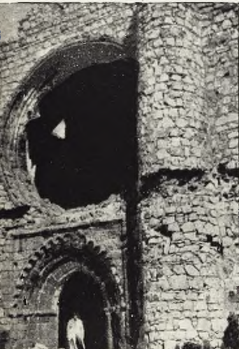
Fachada principal de la Iglesia.
