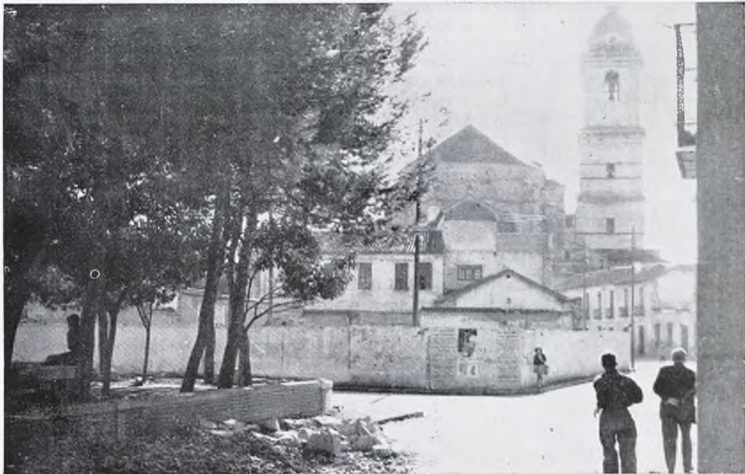
Extensas zonas dentro del casco urbano sin edificar...
