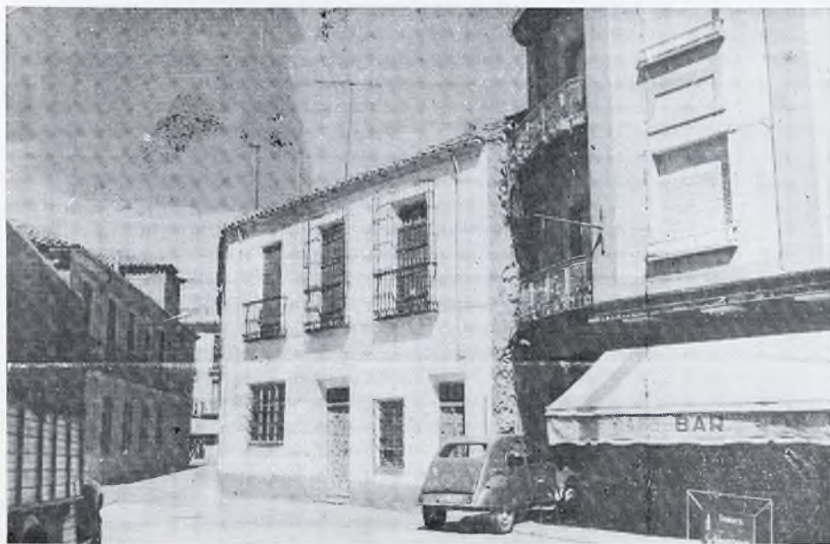
Vista del callejón, desde el otro extremo. Todas las casas de la derecha, hasta la calle de General Aguilera, desaparecen.
